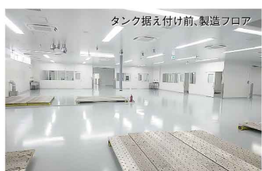
タンク据え付け前、製造フロア
