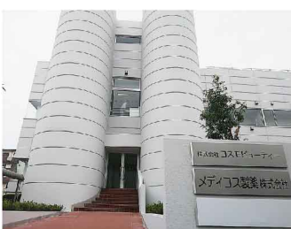
新設した関東第二工場外観
