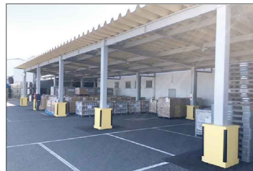
新設下屋の風景②
