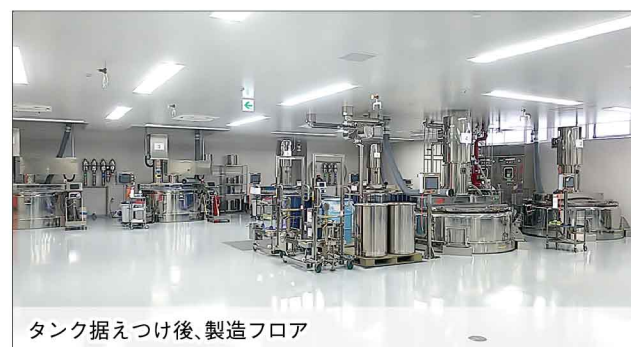
タンク据えつけ後、製造フロア
